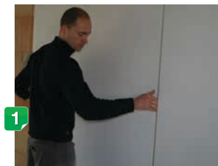
1 - Poser l'isolant Efimur® .
