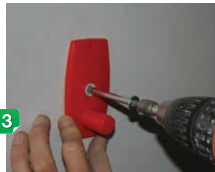
3 - Fixer Eficlic sur le panneau Efimur® .
