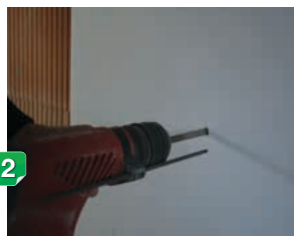
2 - Tracer et percer l'emplacement de l' Eficlic .
